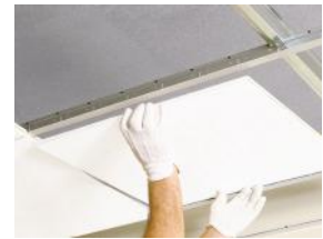
Las placas individualmente son fácilmente desmontables
